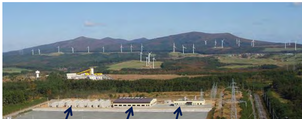
NAS電池 変換器棟 管理棟
